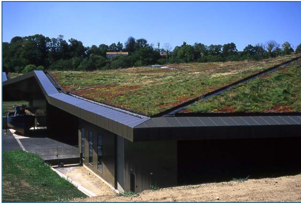
Abb. 4: Mit einem Gründach lassen sich bis zu 70 % des anfallenden Niederschlags zurückhalten.
