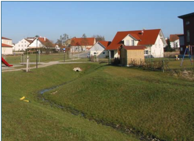
Abb. 7: Eine oberflächige Ableitung begünstigt die Verdunstung und ist kostengünstiger als unterirdische Anlagen.
