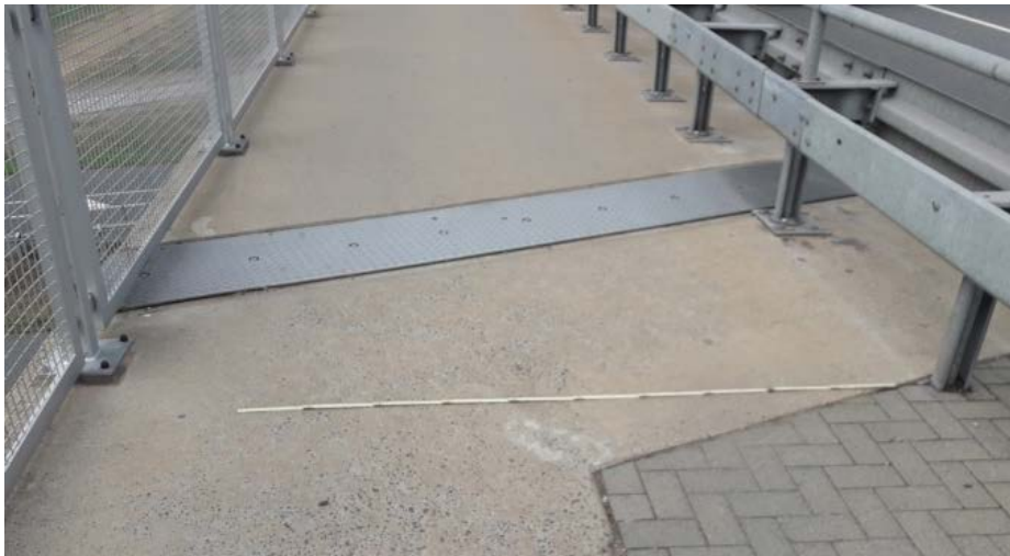
Abbildung 7-23: Netzlücke an der Martinsbrücke St 2309 (Foto: Walter Lauth)
