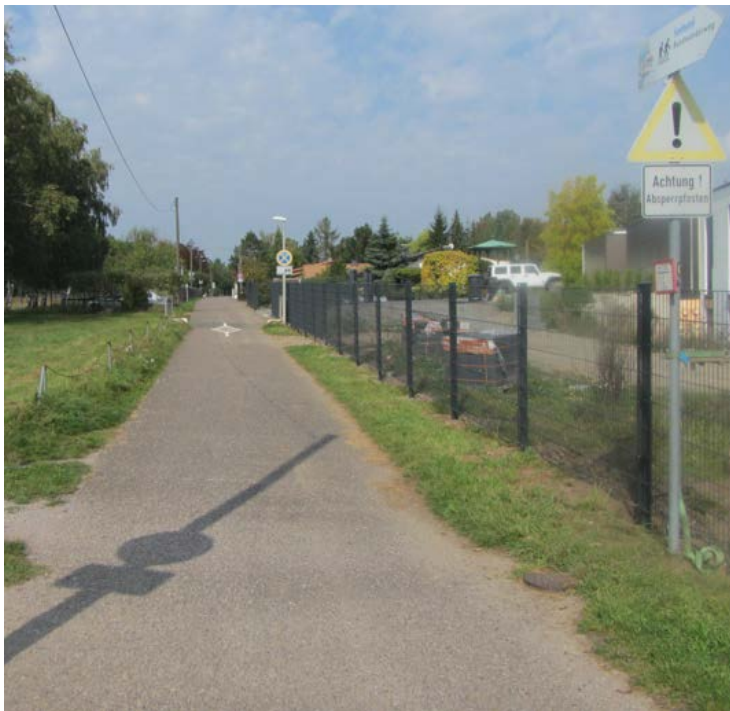
Abbildung 6-31: Markierungen und Beschilderungen zur Sicherung von Sperrpfosten sind z.B. in Niedernberg bereits gut
