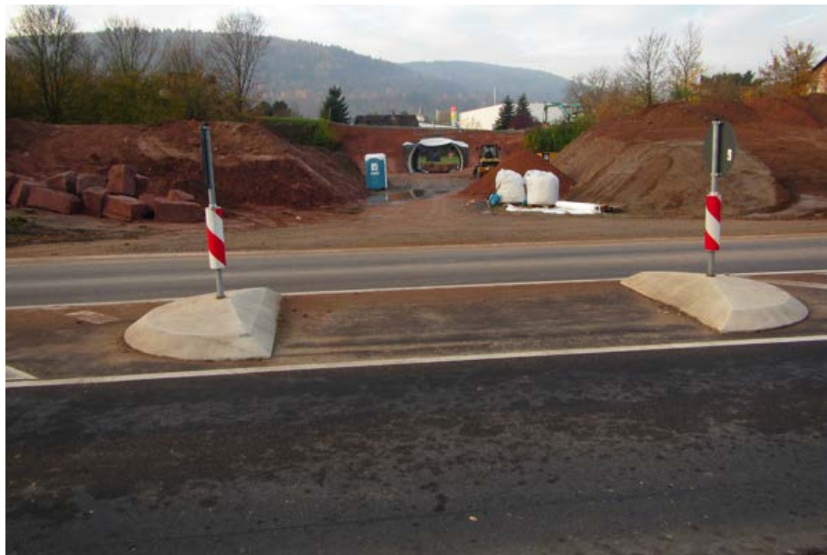
Abbildung 15-1: neue Querungshilfe und Unterführung in Kleinheubach
