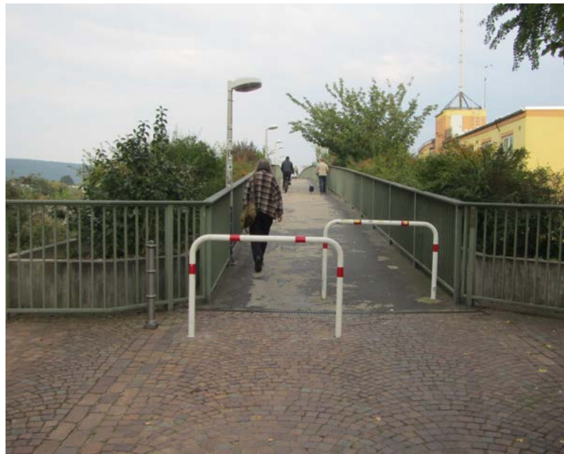
Abbildung 25-1: rege genutzte Fußgänger/Fahrrad-Brücke über den Main zwischen Obernburg und Elsenfeld
