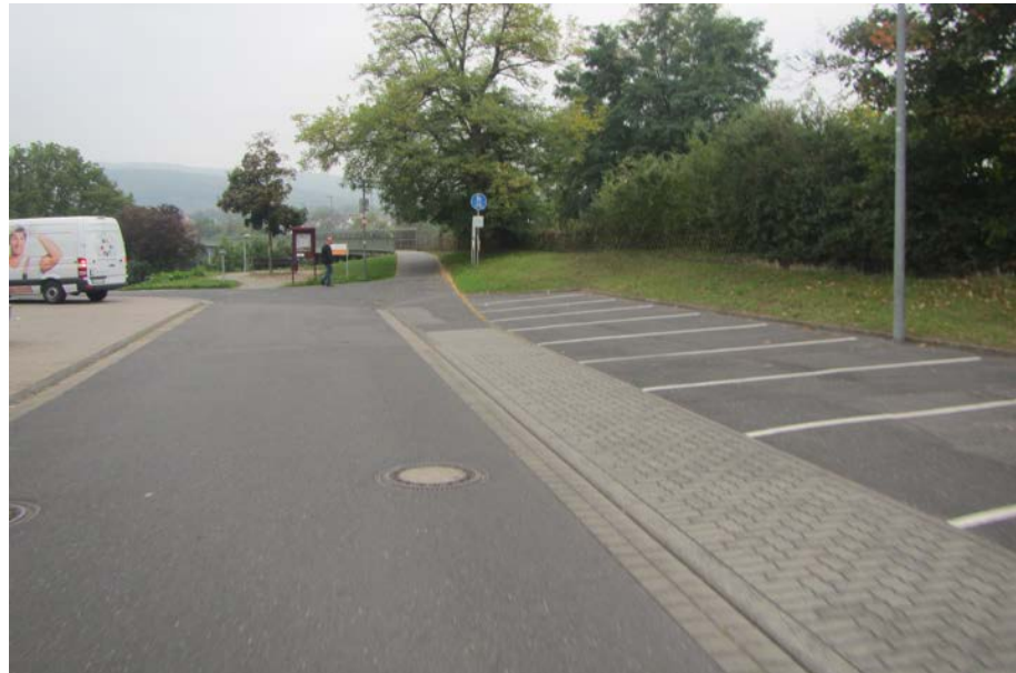
Abbildung 8-2: unbefriedigende Situation für Radfahrer und Fußgänger vor dem Brückensteg
