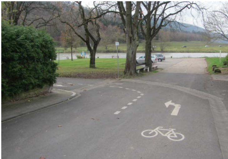
Abbildung 5-2: Markierung einer Mittellinie in unübersichtlichen Kurvenbereichen
