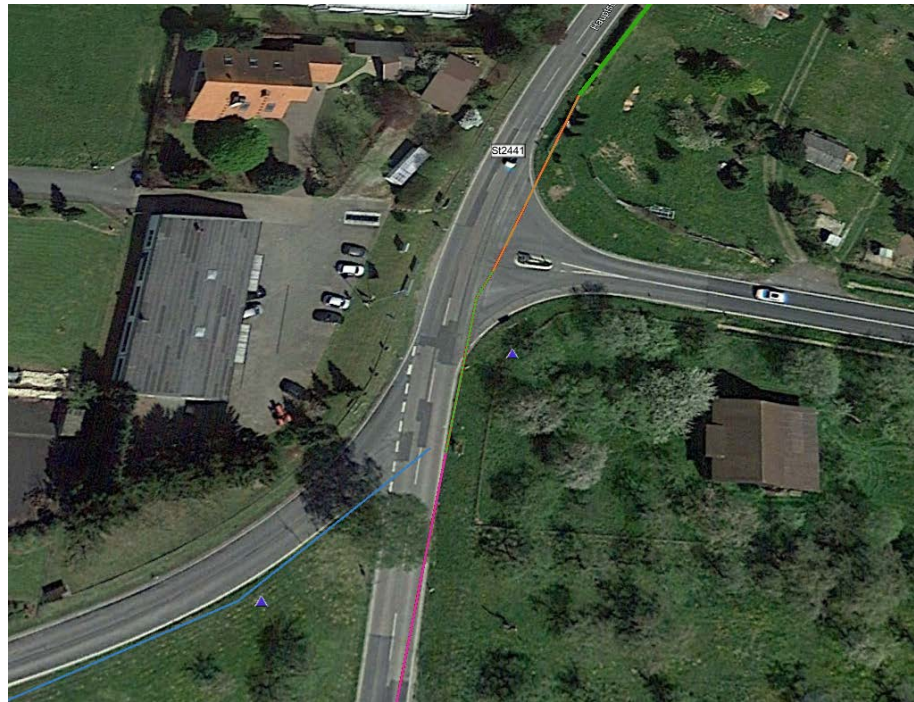
Abbildung 22-3: großflächige Knotenpunkte ohne Fuß- und Radinfrastruktur (hier am Knotenpunkt der St 2441 mit der MIL 2)
