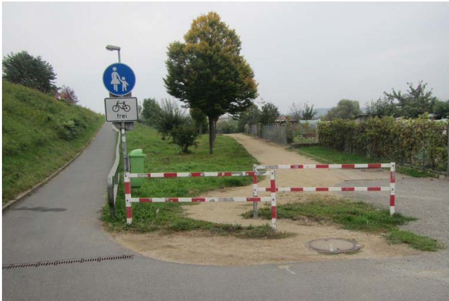
Abbildung 32-2: nicht ausreichende Breiten auf der Rampe
