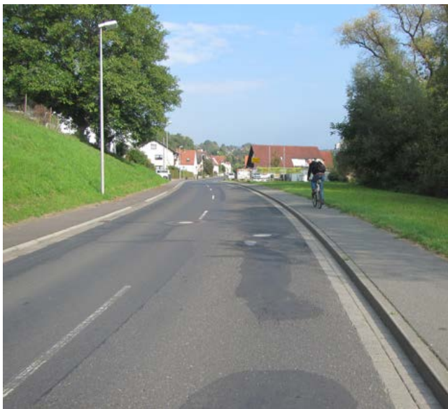
Abbildung 13-1: fehlende Radverkehrsinfrastruktur zwischen Hausen und Hofstetten
