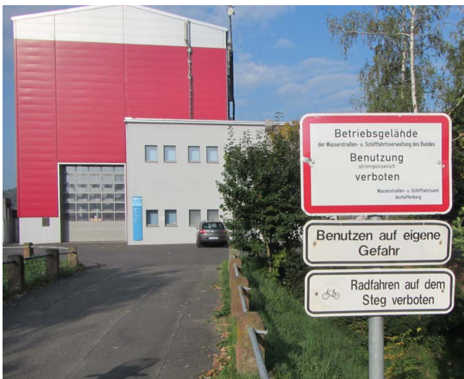
Abbildung 12-2: Auch die Schleuse bietet keine fahrbare Verbindung für den Radverkehr
