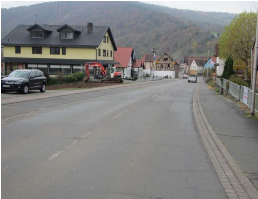
Abbildung 4-5: Die Ortsdurchfahrt wirkt überdimensioniert
