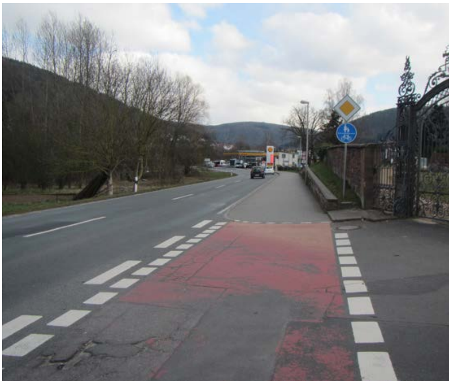
Abbildung 2-4: Optimierung der Furtausgestaltung an Unfallschwerpunkt
