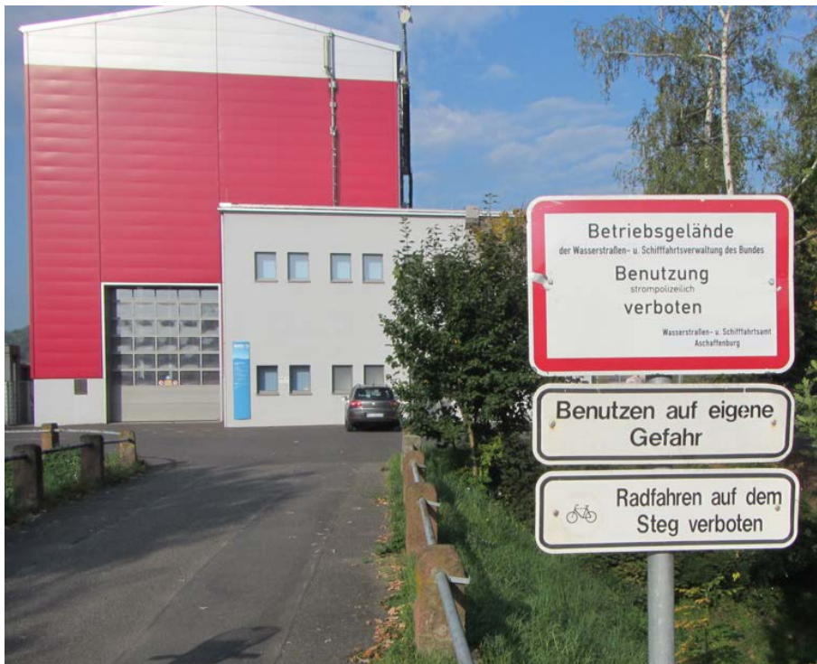
Abbildung 16-3: Auch die Schleuse bietet keine fahrbare Verbindung für den Radverkehr
