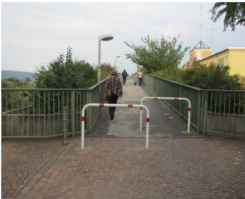
Abbildung 7-1: rege genutzte Fußgänger/Fahrrad-Brücke über den Main zwischen Obernburg und Elsenfeld
