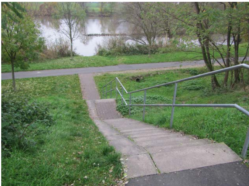
Abbildung 11-3: Umbau der Treppe in eine barrierefreie Rampe
