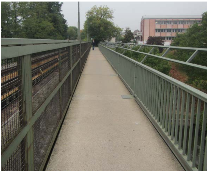
Abbildung 8-1: schmaler Steg für Fußgänger und Radfahrer an der Eisenbahnbrücke zwischen Erlenbach und Wörth
