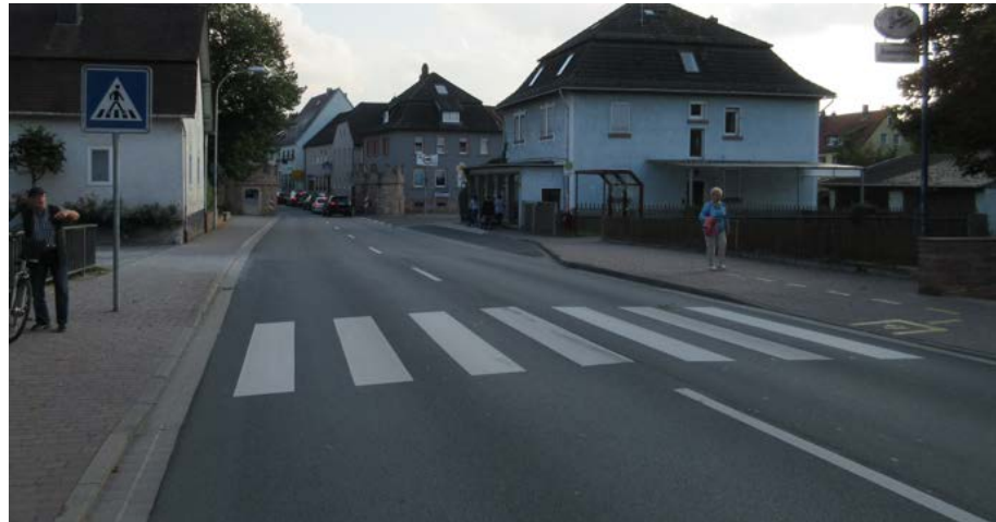
Abbildung 30-2: Sulzbach: Fußgängerüberwege sichern an vielen Stellen die Querungsbedarfe für Fußgänger
