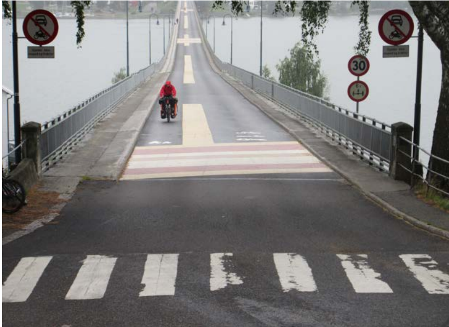
Abbildung 20-2: Umweltverbundbrücke in Lillehammer (Norwegen)
