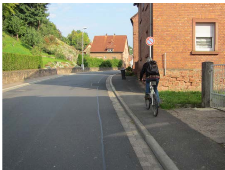
Abbildung 13-3: ein einseitiger Schutzstreifen in Richtung Kernort sichert den Radverkehr auf der Fahrbahn
