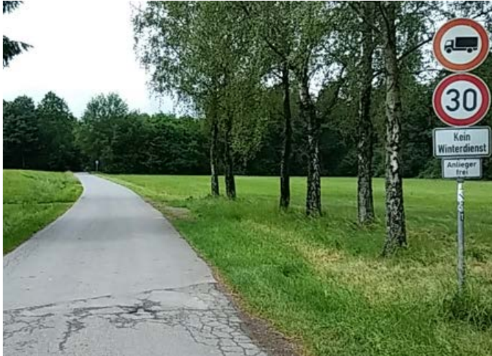
Abbildung 2-6: Reduzierung der Höchstgeschwindigkeit für Kfz auf schwach belasteten Straßen bei Beuchen
