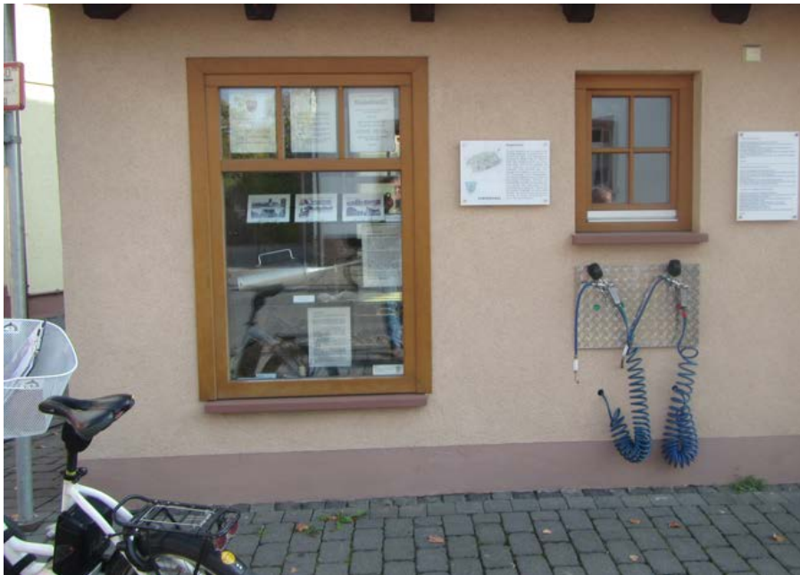
Abbildung 24-2: Öffentliche, fest installierte Luftpumpe im Ortskern von Niedernberg
