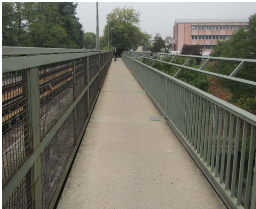
Abbildung 32-1: schmaler Steg für Fußgänger und Radfahrer an der Eisenbahnbrücke zwischen Erlenbach und Wörth
