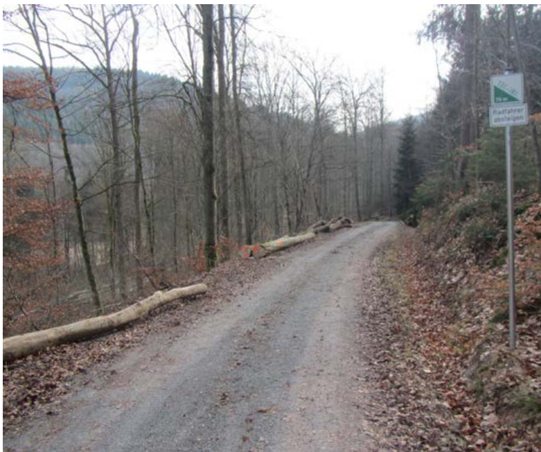
Abbildung 6-3: Hinweise auf starkes Gefälle werden in der Wegweisung gegeben
