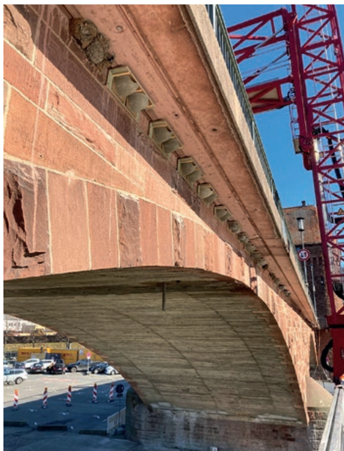
Mehlschwalben-Kunstnester als Ausgleich für entfernte Nester. Hier: Mainbrücke Miltenberg. © Staatliches Bauamt Aschaffenburg
