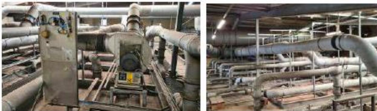
**Bild 8 und 9:** Belüftung Intensivrotte
