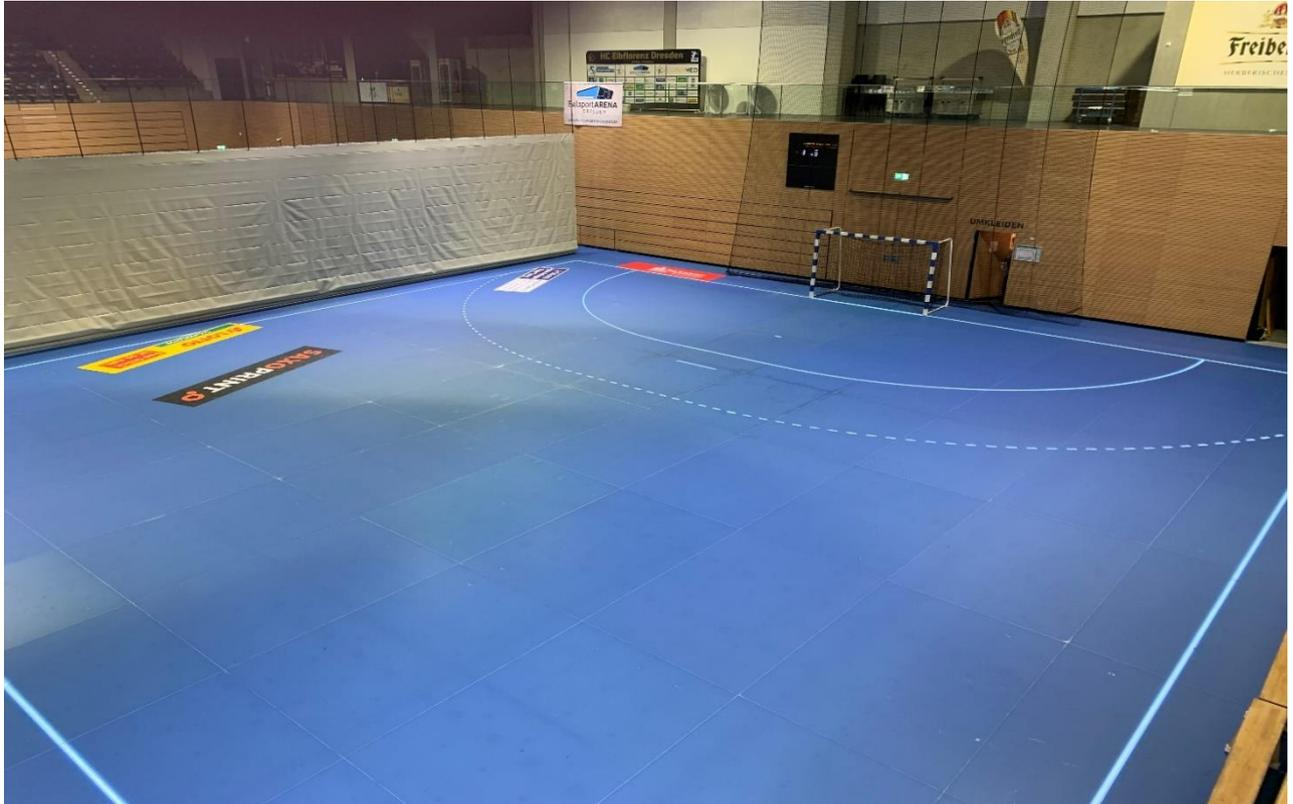
Deutlich erkennbar sind die verschiedenen Farbnuancen der Platten und die Farbfehlstellen insbesondere an den Plattenkanten. Auch deutlich sichtbar waren Harzrückstände auf der Fläche.
