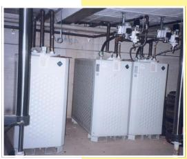
nung) nun Heizöltanks, Kellertanks sowie Batterietanks. mit einem Gesamt-fassungs-vermögen (maßgebend ist das Typenschild), von mehr als 10.000 l Inhalt alle 5 Jahre prüfpflichtig sind.
