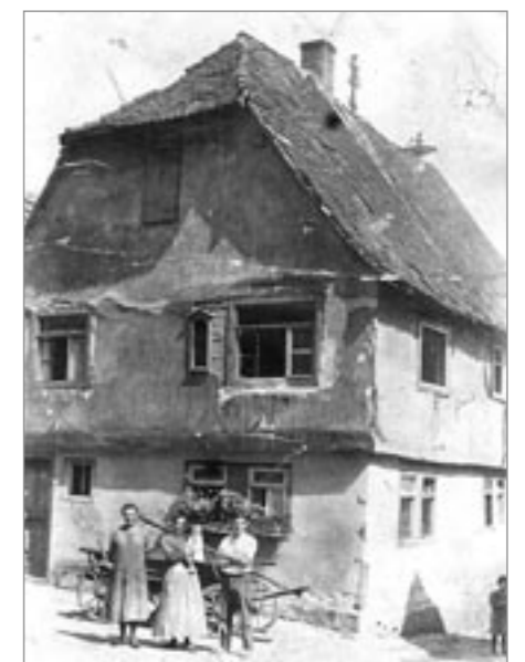
Baudenkmal Obere Gasse 13 in Obernburg – um 1925
