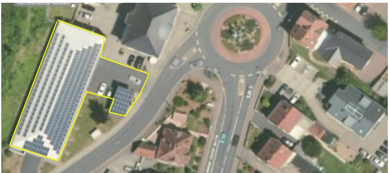
Parkhaus Wendelinuskreisel, der Öffentlichkeit zugänglichen und nutzbaren Bereichen, einschl. der unteren Zufahrt ins Parkhaus vorgelagerter Parkflächen
